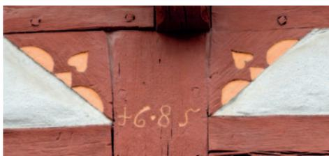
*Die Vertiefungen am Kopfwinkelholz hätten mit dem Gefach ausgeputzt werden sollen, um „Augen und Nasen“ hervorzuheben.*
